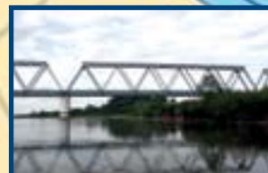
Most kolejowy (Zaduszniki) relacji Majdan Królewski- Staszów, H= 11 m przy WWŻ
