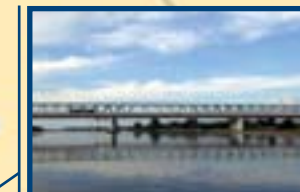
Most drogowo-kolejowy (Nagnajów), relacji Radom-Rzeszów H= 4,5 m przy WWŻ
