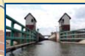
Śluza Smolice widok od wody dolnej
