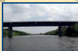
Most drogowy H = 8,88 m przy WWŻ
